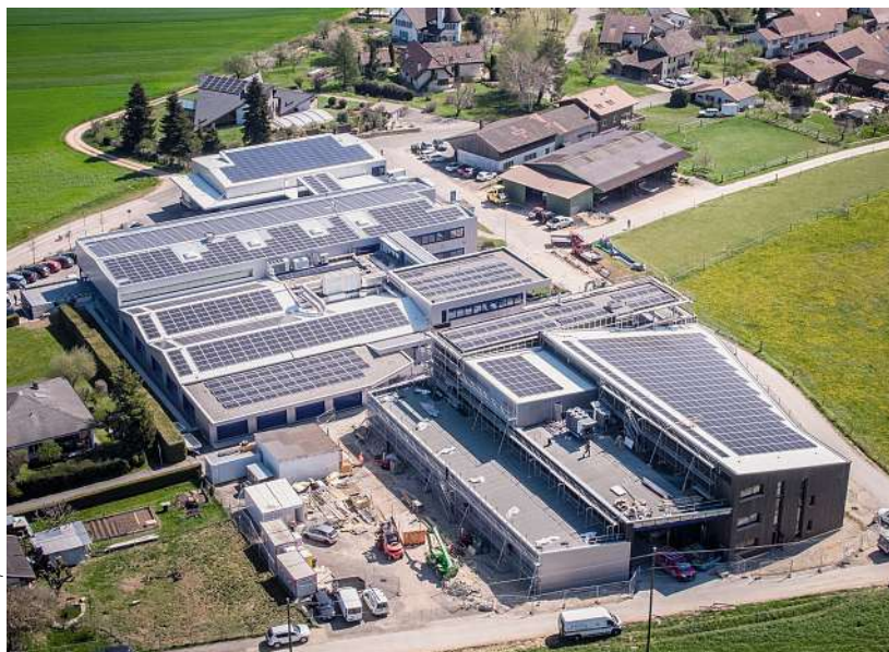
Der Standort von Recomatic in Courtedoux im Jura. Das Unternehmen produziert 40 Prozent seines Strombedarfs mit zahlreichen Photovoltaikmodulen auf den Dächern seiner Gebäude selbst.
